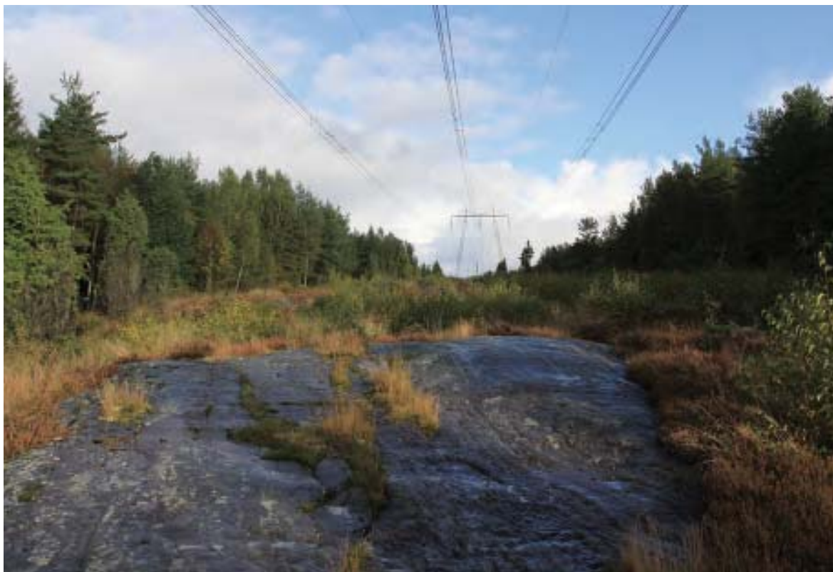
Befintlig 400 kV-ledning vid stationen i Stenkullen.
