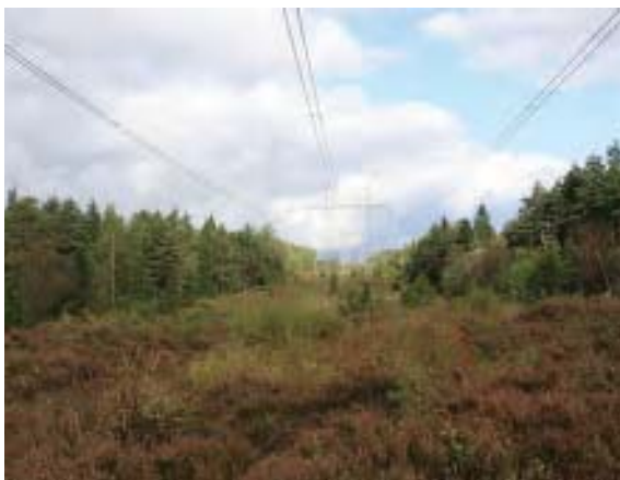
Exempel på ledningsgata i skogsmark, sydost om Öresjö.
